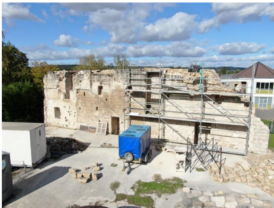
Fig. 3 : Saint-Médard de Soissons. Élément de rempart dans l'angle nord-ouest de l'enclos monastique en cours de restauration (Ville de Soissons, octobre 2021).
